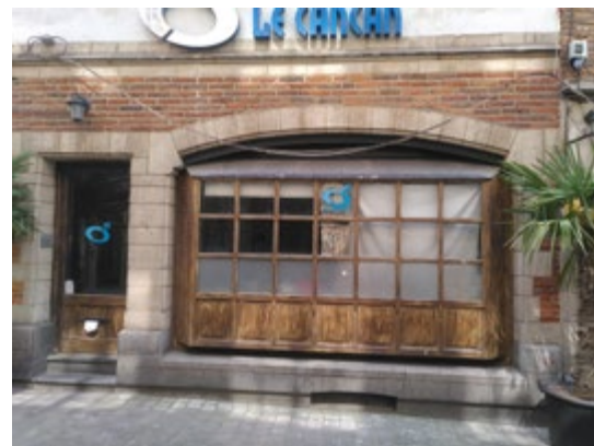
Rue des Pierres, 53
