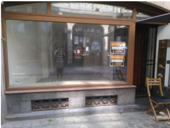
Rue des Pierres, 51
